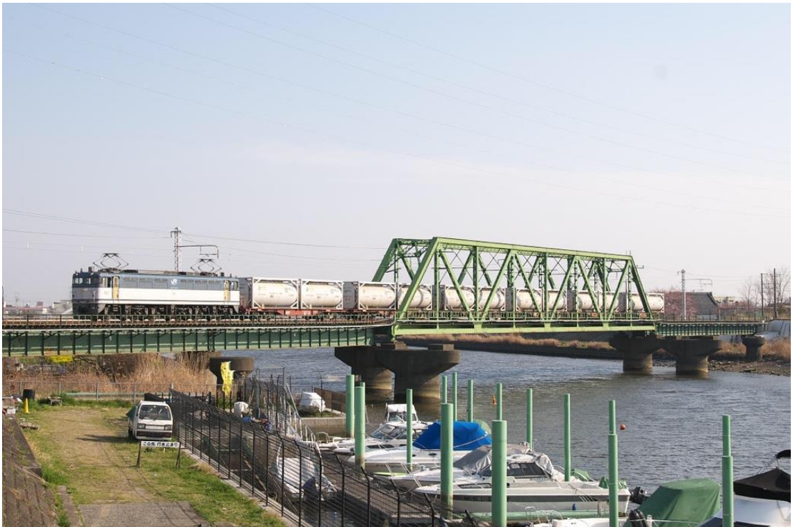
↑ 中川放水路橋梁と貨物列車の図
